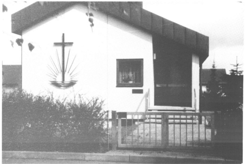
Blick von vorne (Straßenseite)
