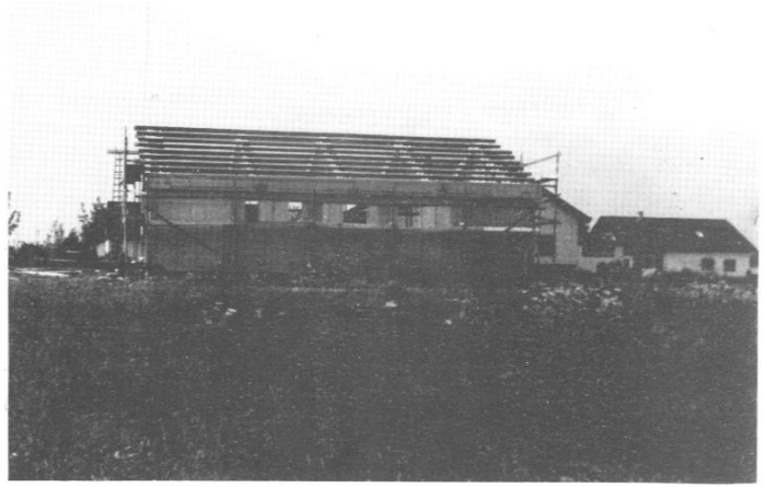
Die neue Kirche kurz vor der Fertigstellung des Rohbaus
